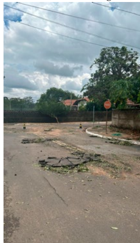
Rua Massaranduba, no bairro Parque dos Ipês
