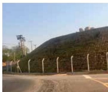
*Talude e alambrado encostado na estrada, não mantiveram espaço suficiente de recuo obrigatório*
